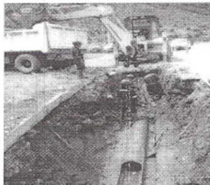
Reparación de línea de conducción altura del tecnológico
