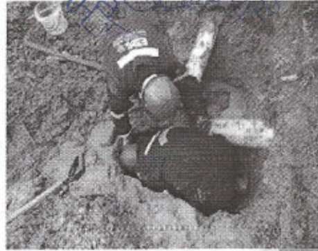
Reparación de fuga de agua en Jr. Libertadores Ascención
